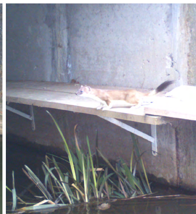
Dřevěné lávky podél stěny mostu velmi dobře zlepšují průchodnost savců.
